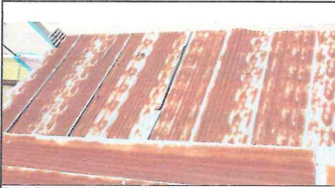
Foto1: Estado del techo de las aulas deterioradas por el tiempo
