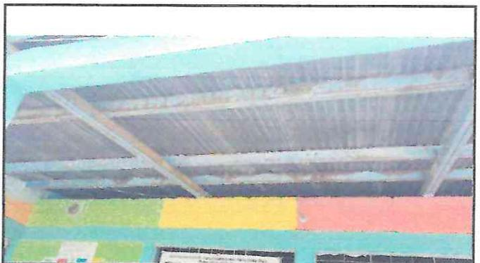
Foto 4: Estructura destruida por corrosión
