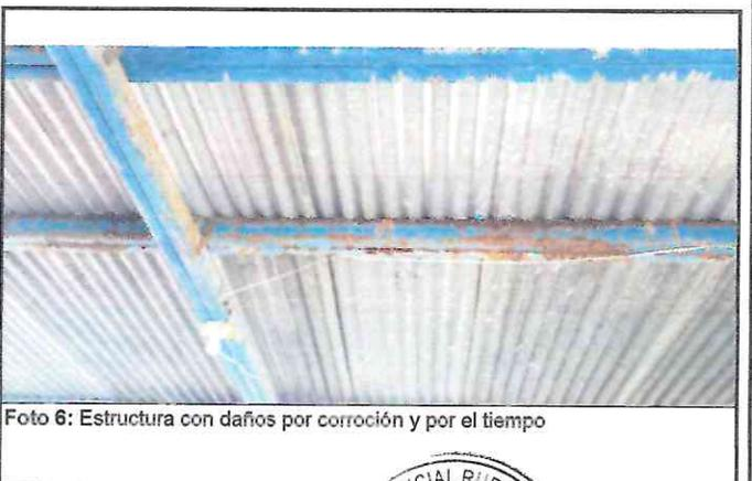
Foto 6: Estructura con daños por corrosión y por el tiempo
