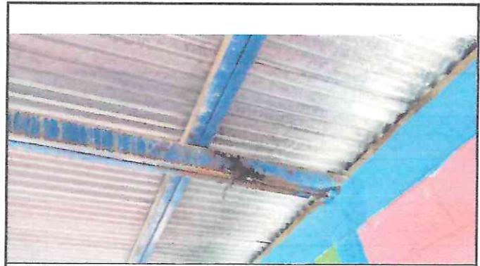
Foto 2: Situación actual de la estructura metálica de soporte del techo de las aulas, destruidas por filtración de agua
