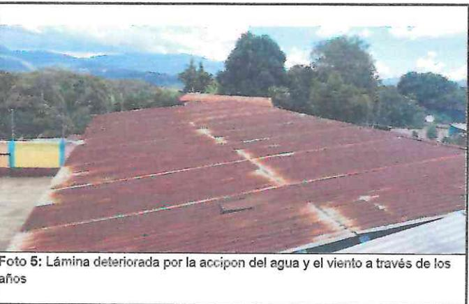
Foto 5: Lámina deteriorada por la accipion del agua y el viento a través de los años
